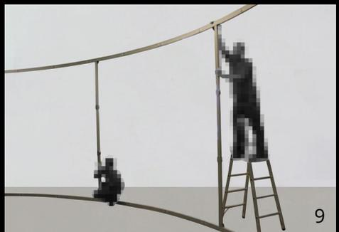
8-9 die obere Traverse mit mindestens 3 Personen auf die Vertikalprofile setzen und verschrauben.
